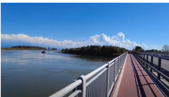
Ponte sul Canale Primero
